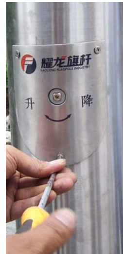
图 3-14 手动装置安装图
